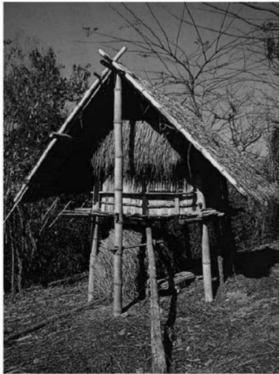
写真・図2 アカ族の高床式穀倉。若林弘子『高床式建物の源流』弘文堂より。
